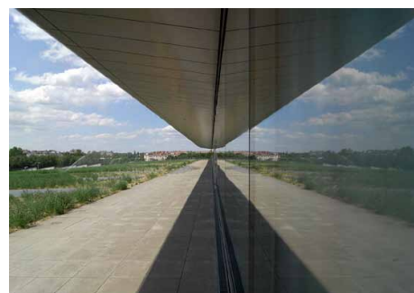
Glasfassade Ebene E3
